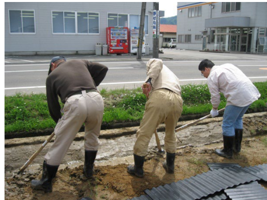
側溝から不要な土を出します。
