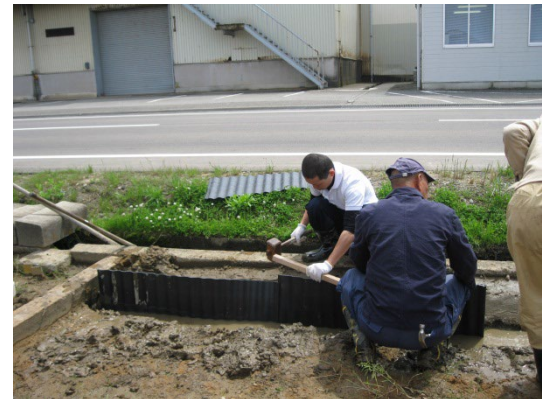
側溝から水が漏れないように板をはめ込む作業です。
