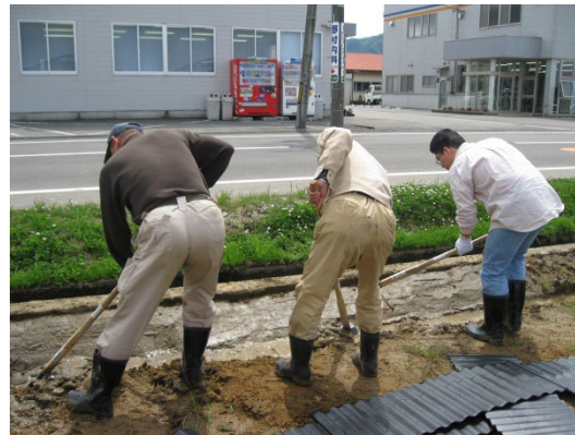
側溝から不要な土を出します。
