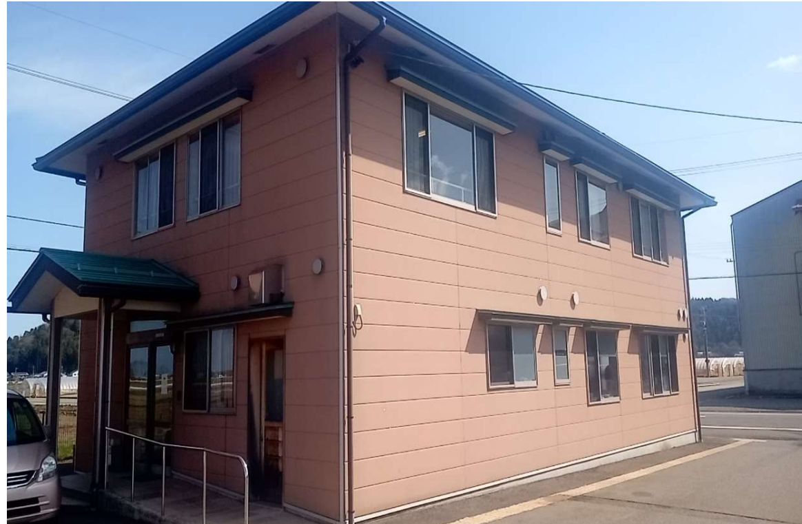
ファーム事務所、休憩室
